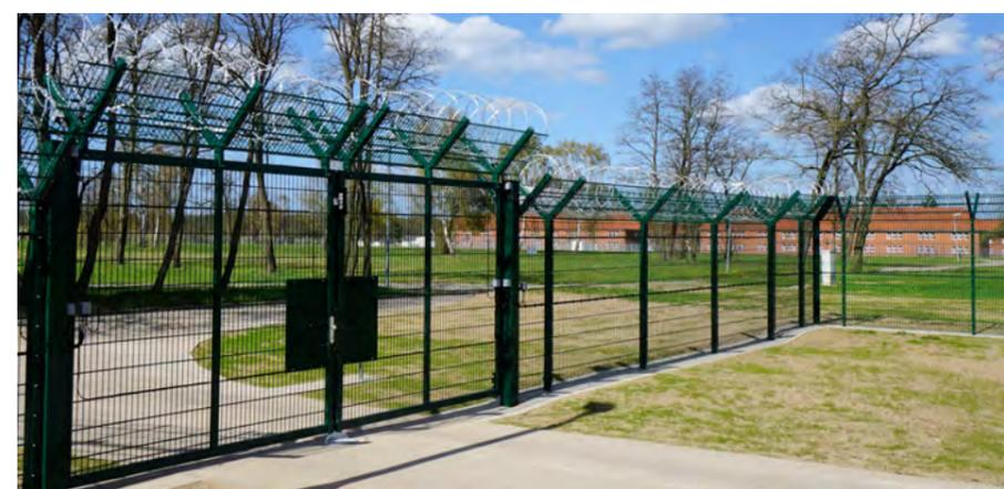
2-flügeliges INOVA Drehflügeltor mit mechatronischer Übersteigsicherung
